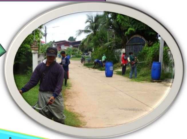
ทำความสะอาดไหล่ทาง
